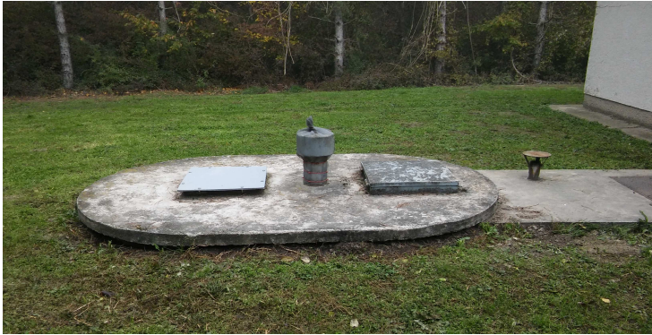
Aussenansicht Vorschacht Bohrbrunnen
